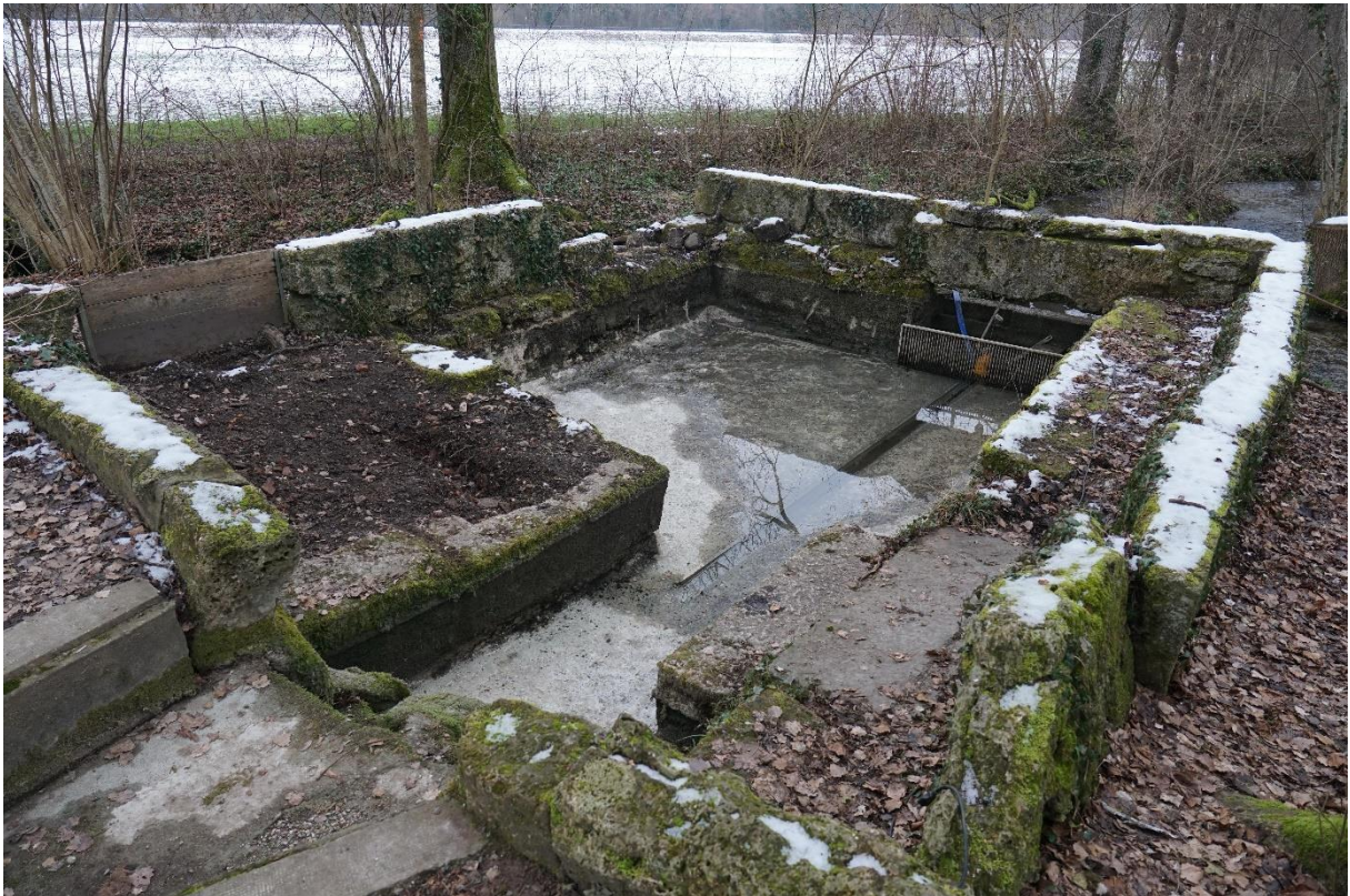
Abbildung 1: Die Reste des Pumphäuschens im Schlosspark. Aktuelle Aufnahme Januar 2023
